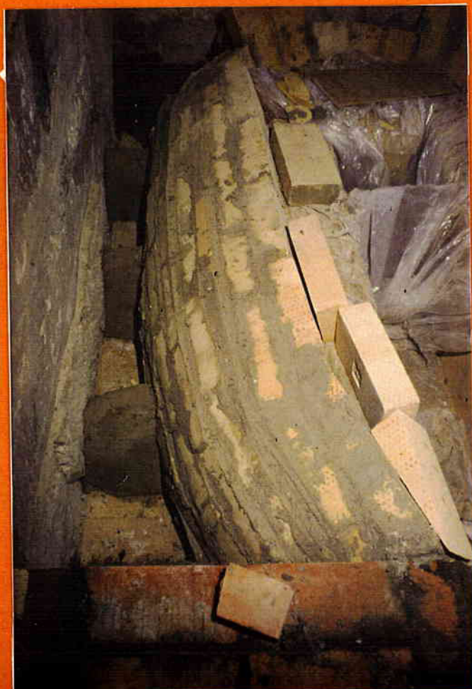
Mauern zum Gewölbeaufbau
