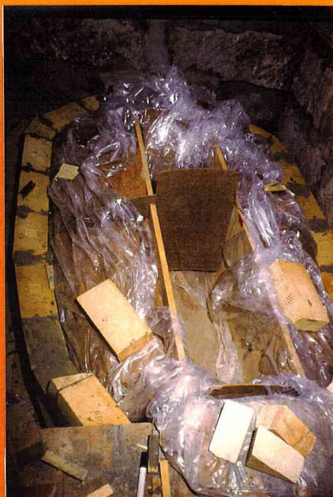
Sandform zum Gewölbeaufbau
